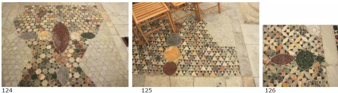
Figg.124,125,126: riassetblaggio casuale di dischi e tessere grandi oblunghe nel pavimento ricostruito.
